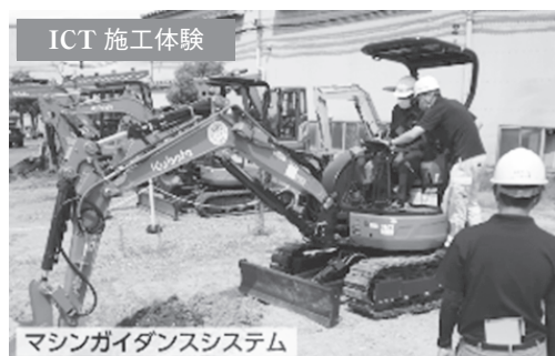
③ ICT 施工対応バックホウ
