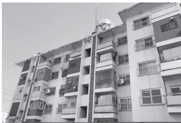
写真－2 整備前の市営住宅
