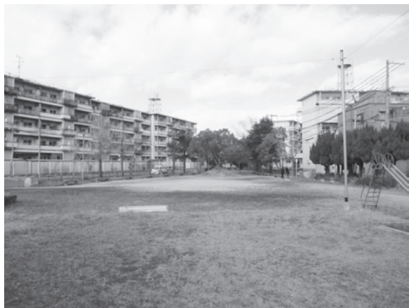
写真－3 整備前の鎌池公園
