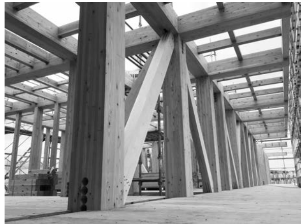
写真-3 建設中の県営住宅(構造用集成材と大断面の筋違い)
