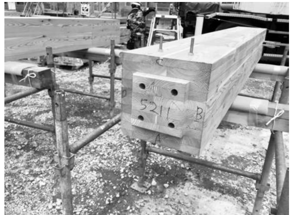
写真-4 燃えしろ層を確保した構造用集成材
