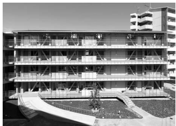
写真-5 完成した「あらわし木造4階建て県営住宅」
