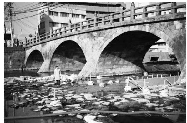
写真－6 撤去直前の西田橋（河床には石が敷き詰められていた）
