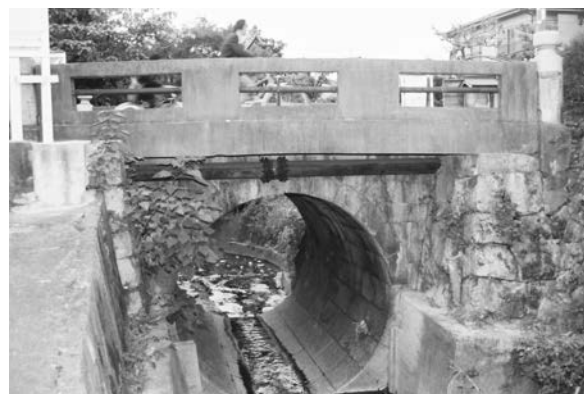
写真－14 伏見街道第四橋
