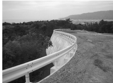
写真 4 完成した状況
