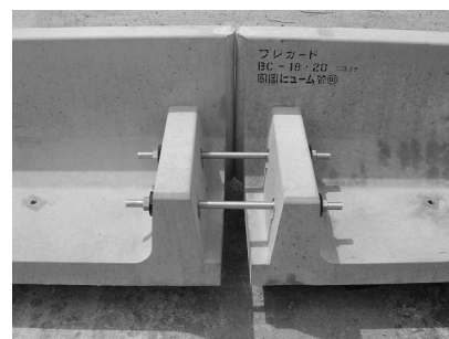
写真 2 連結金具接続状況
