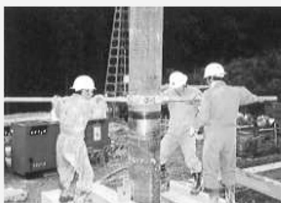
継手部の接続
