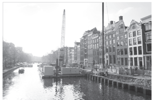
写真-3 岸辺に並ぶ歴史的な建物群を前に、無振動・無騒音の電動化した圧入機が活躍
