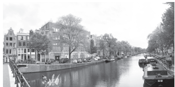
写真-2 施工前の現場の様子
