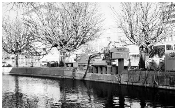
写真-5 デン・ハーグ市での施工の様子
