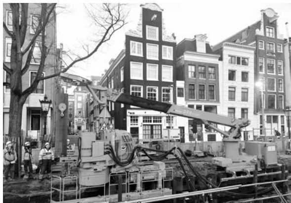
写真-4 街路樹を撤去することなく施工
