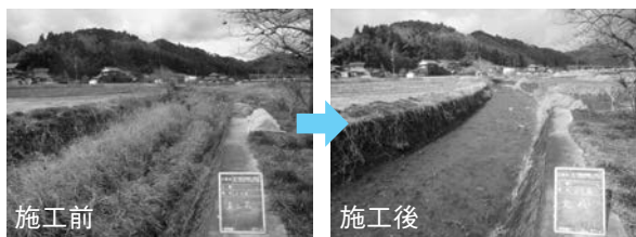
写真-2 河川浚渫
