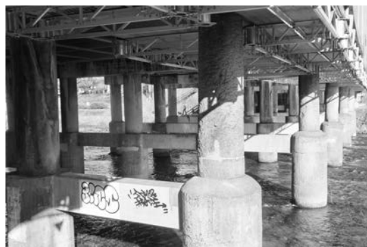
写真-5 現在の三条大橋 下流側の石造橋脚
