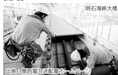
送電網の収容に道路空間を活用
