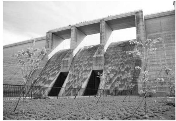
写真-3 稲葉ダム SWL 到達時の越流状況
