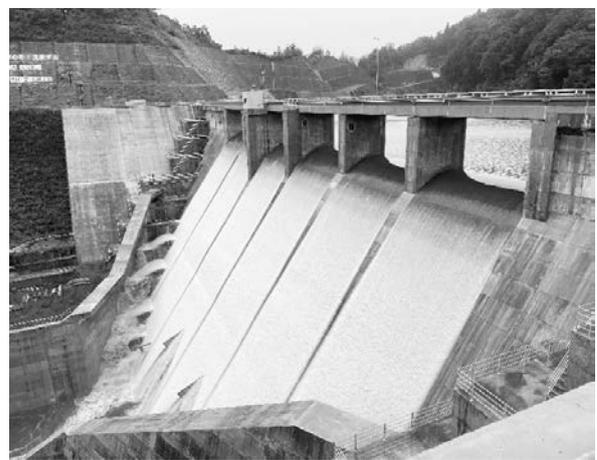
写真-4 玉来ダム SWL 到達時の越流状況
