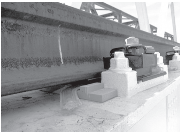
写真-4 枕木が省略された鋼直結軌道
