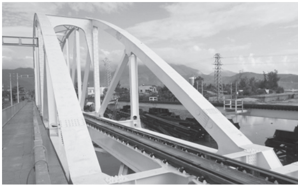
写真-3 錆の進行を抑制する耐候性鋼板を採用
