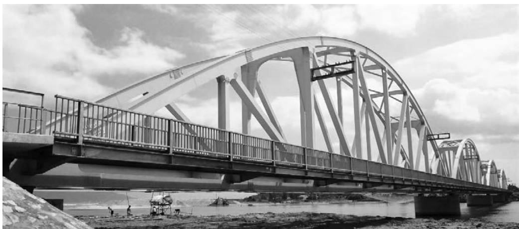
写真-1 改修が完了した Nam O 橋（ダナン市）
