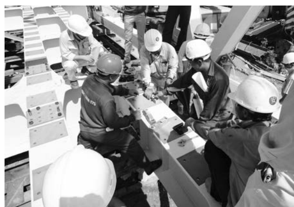
写真－8 各橋梁における技術講習会
