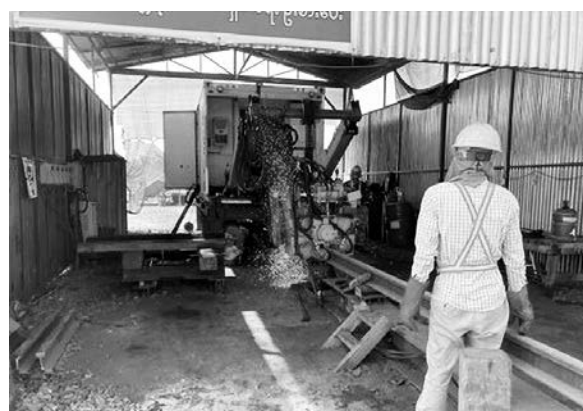
写真－9 フラッシュバット溶接（ミャンマー）
