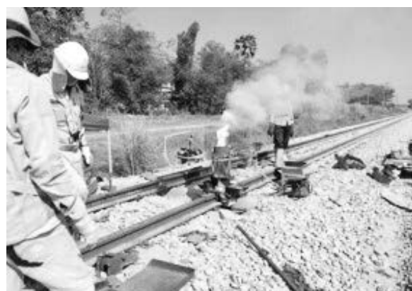
写真－10 テルミット溶接（ミャンマー）
