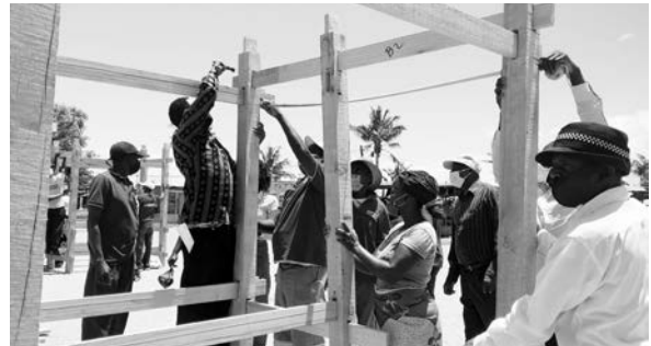
木組み屋台の組立・解体訓練
