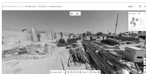
コンクリート工事 (2021年8月時点)
