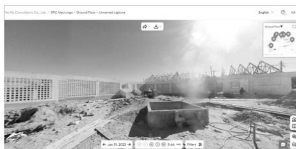
コンクリートブロック工事・屋根工事 (2022年1月時点)
