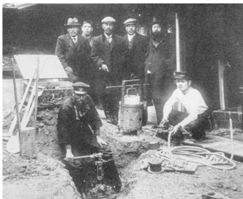
写真-1 最初の水道管敷設工事（1911年ころ）
