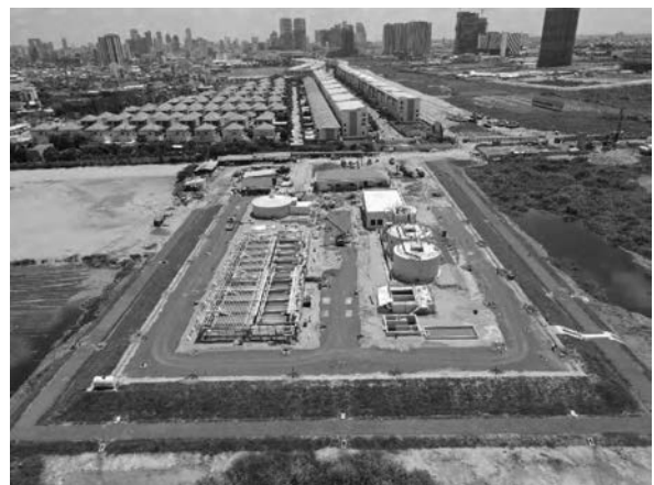
写真－9 カンボジアの首都プノンペンでは初となる公共下水処理場が建設中
