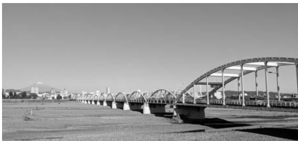
写真－1 安倍川右岸から安倍川橋・富士山を望む
