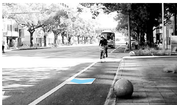
写真-9 矢羽根の設置
