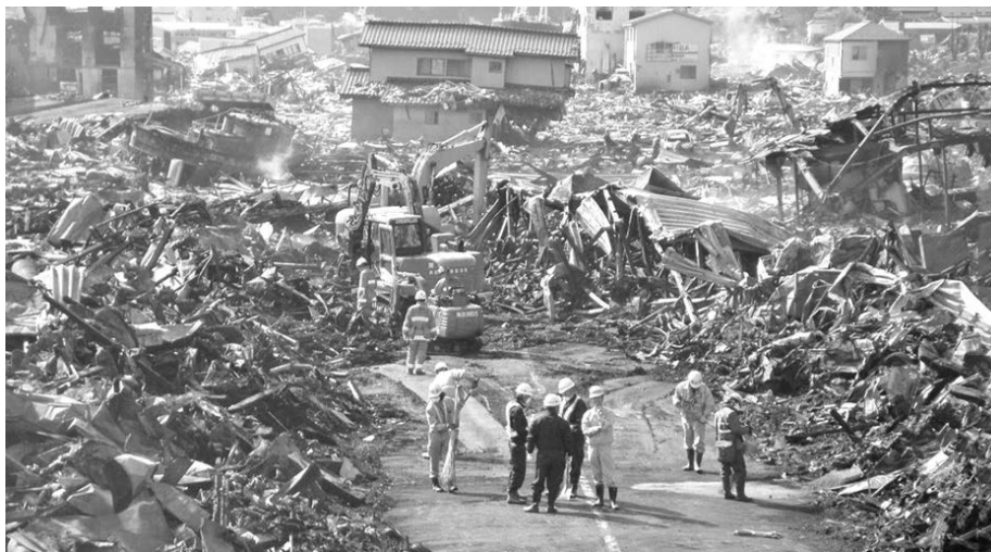
写真－1 東日本大震災における道路啓開（出典：国土交通省 東北地方整備局）
