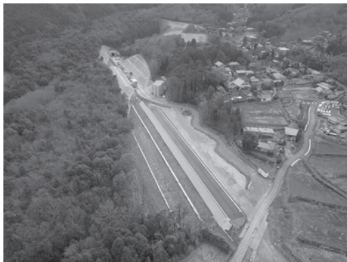
写真－1 茨城県内の山岳トンネル工事の状況
