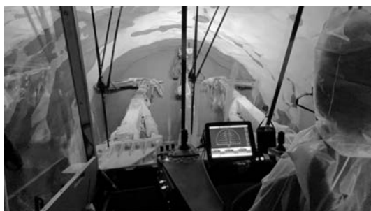
写真-3 自動化による削孔状況
