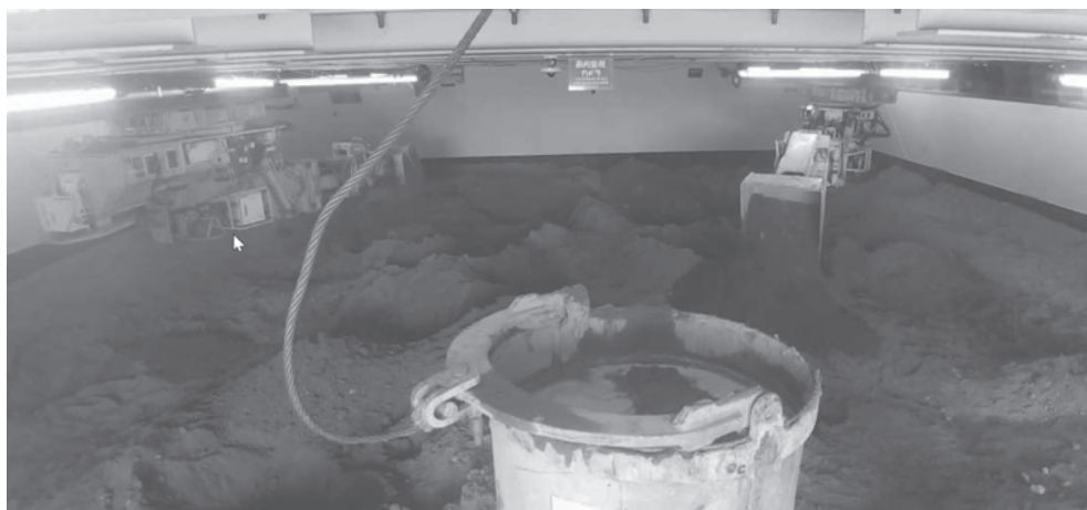
図-4 1人が2台のケーソンショベルを自動運転させる様子
