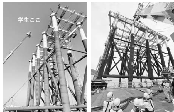
(a) メタルジャケット製作工場+据付工事現場
