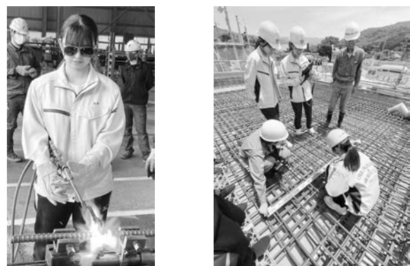
(b) 鉄筋加工工場+RC床版の配筋現場
