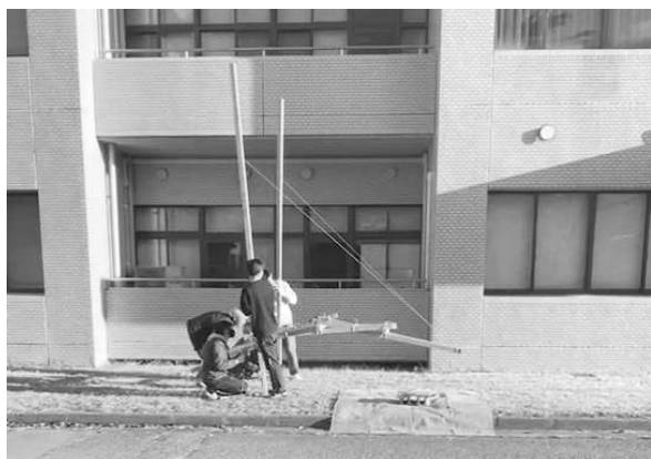
写真－6 タワーを利用した架設
