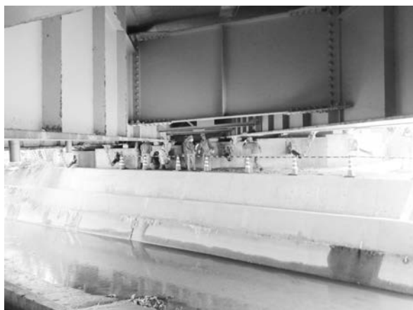
写真-1 橋梁点検実施の様子①
