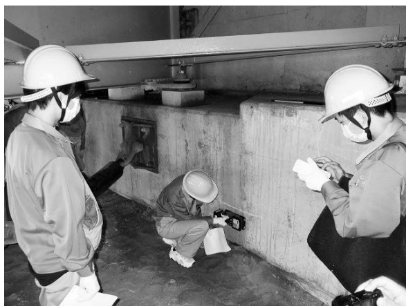
写真-3 橋梁の諸調査の様子
