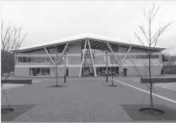
写真－10 完成した女川駅（写真：筆者）
