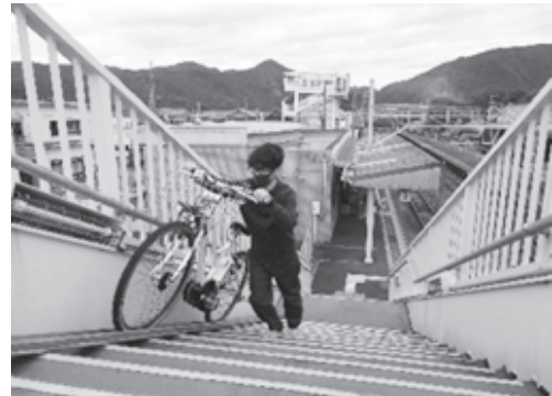
写真－3 階段へのスロープ設置
