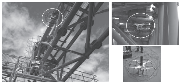
図-11 UAVによる橋梁点検
