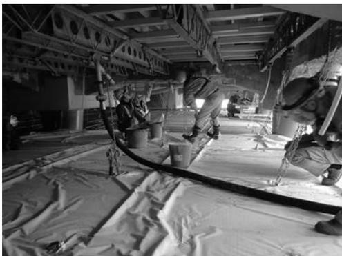
写真-8 床版下面への圧送状況
