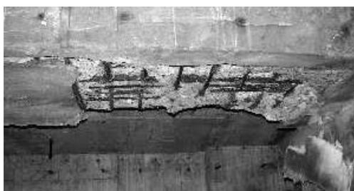
写真-1 塩害により劣化した栈橋の例
