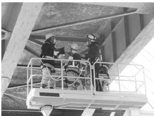
写真-3 橋梁点検の様子（盛岡工業高校）
