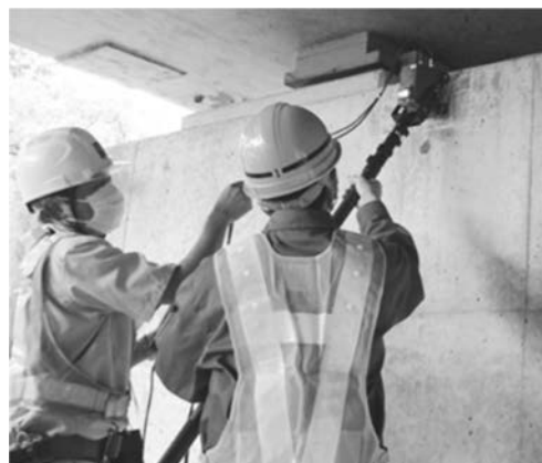
写真-1 橋梁点検の様子（R3 黒沢尻工業高校）
