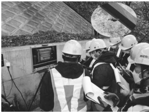
写真-2 橋梁点検の様子（一関工業高校）
