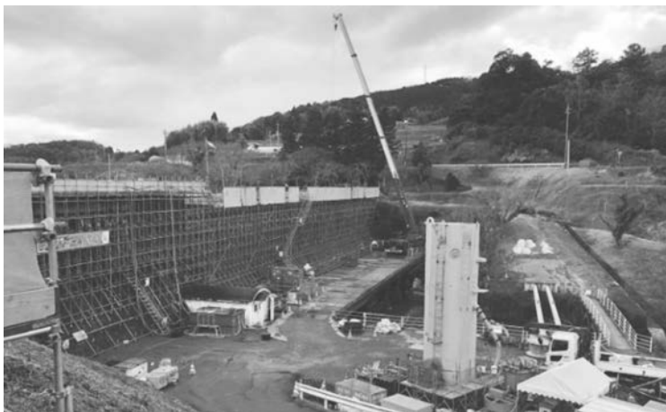
写真-2 施工時全景
