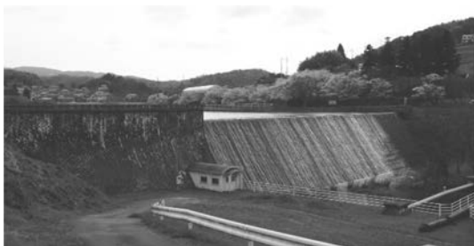
写真-1 千本ダム全景（工事前）
