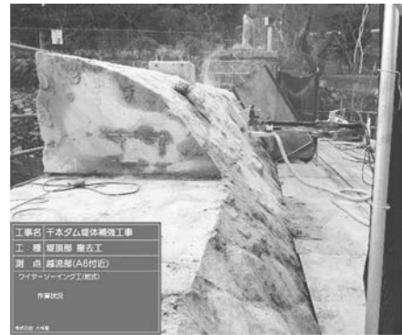
写真-5 既設石積み切取り面
