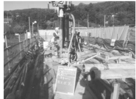
写真-3 削孔状況
