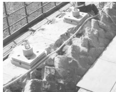
写真-6 既設石積み撤去完了
