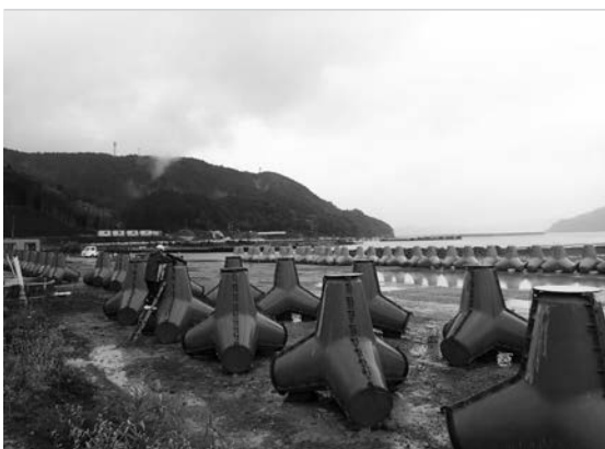
写真－5 消波ブロックの製作（写真：筆者）
