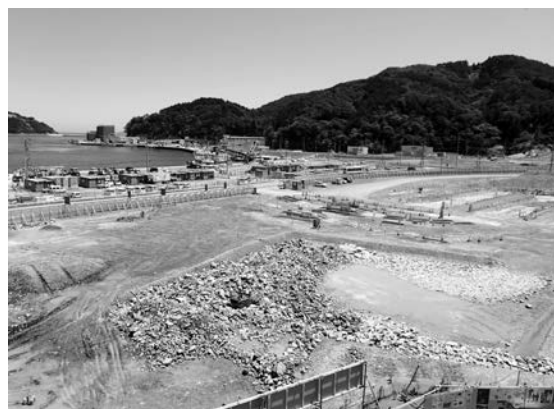
写真－2 港の背面に防潮堤を兼ねた国道が配置された（写真：筆者）
