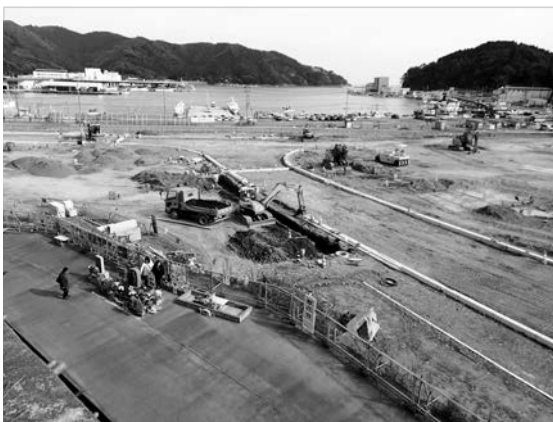
写真－4 防潮堤（国道と兼用）背面盛土部で進む街区道路整備と慰霊碑（写真：筆者）
