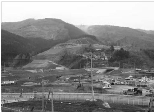
写真-8 工事は切土部と盛土部が同時に施工されていく (写真:筆者)
