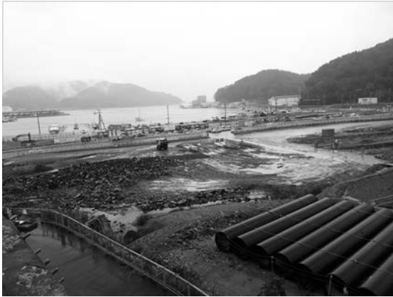
写真－3 防潮堤（国道と兼用）の背面に高く盛土を行う（写真：筆者）
