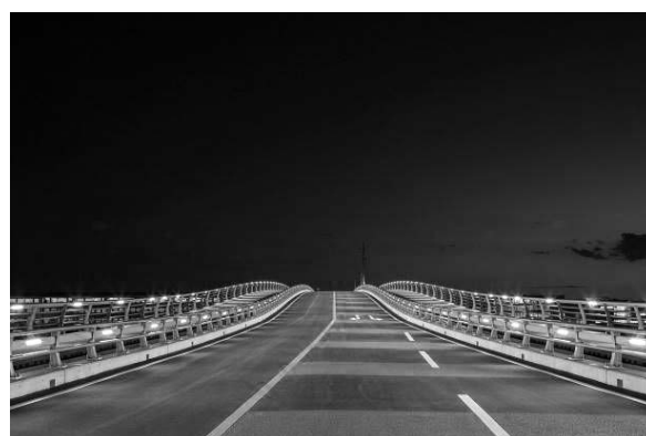
写真－8 照明点灯状況
