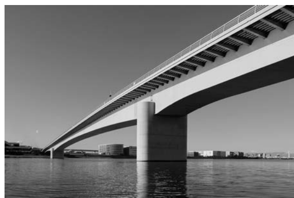
写真－7 橋梁側面
