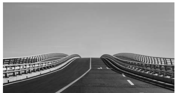
写真-4 高欄・防護柵全景
