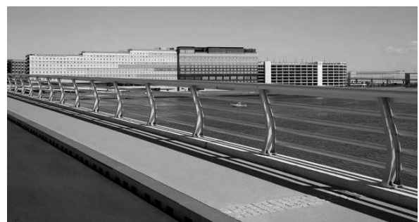
写真-5 設置した高欄
