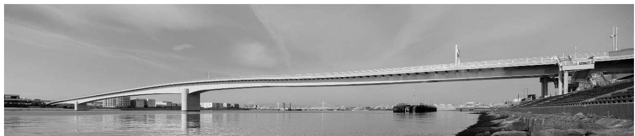
写真-2 橋梁全景
