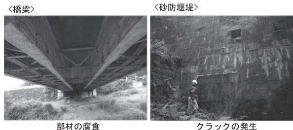
写真－1 腐食・損傷の状況
