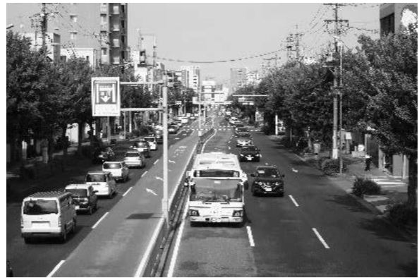
写真-2 BRT 専用レーンの整備 愛知県名古屋市 (市基幹バス新出来町線)
