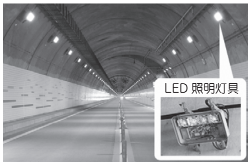
LED照明灯(トンネル内)の設置
