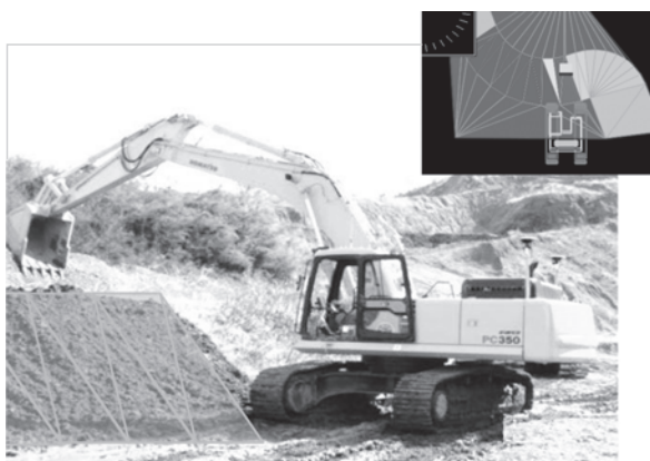
ICT建機による施工
