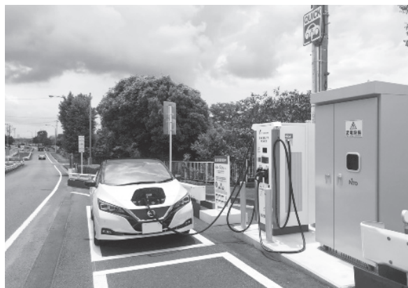
写真-1 道路上の充電機器の設置事例 (社会実験(横浜市, 県道140号線))
