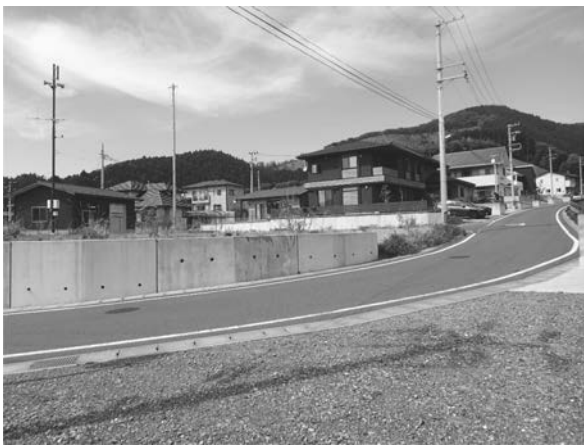
写真－4 100坪で造成された高台住宅地②(写真: 筆者)
