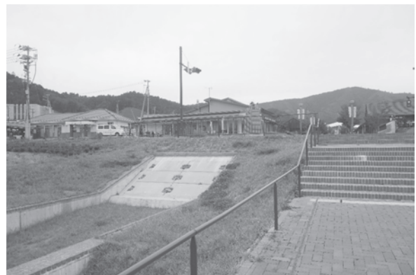
写真－2 防潮堤を隠し込んだ国道（写真：筆者）
