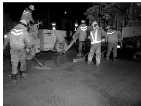
写真1 保水性グラウトの充填状況 3)
