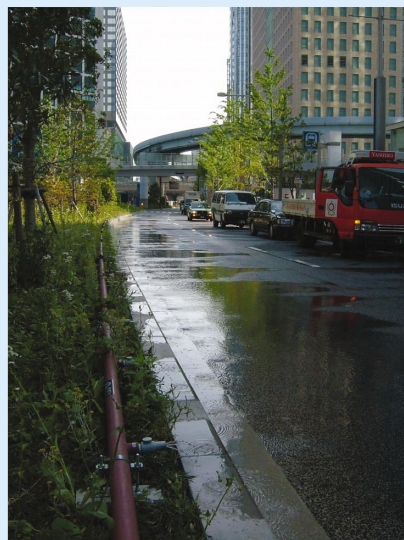
図 4 下水道再生水散水の様子（汐留）
