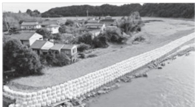
写真－2 大型土のう製造機「クイックホッパー」と令和元年東日本台風被害の応急復旧状況
