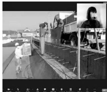
写真-3 コンクリート打設状況確認
