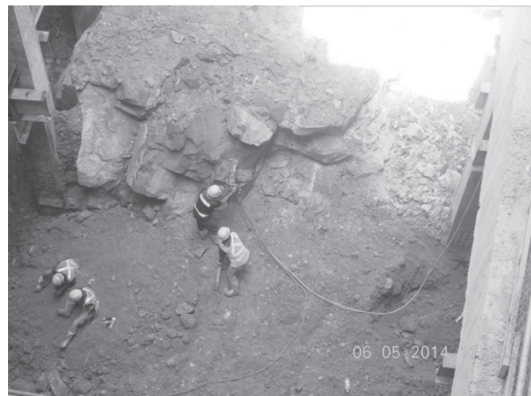
写真－5 駅掘削時のFCBB層の全景
