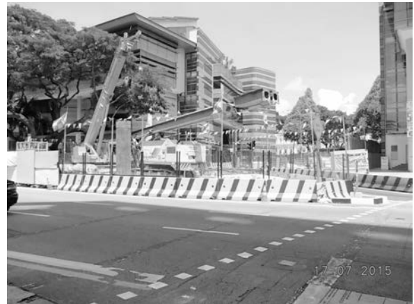
写真-7 ブラスバサ道路内での施工状況
