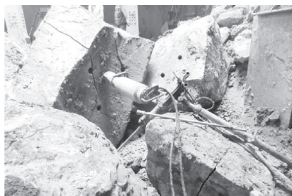
写真－6 静的破碎材の施工
