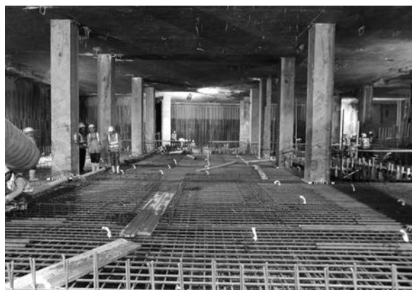
写真-1 逆巻工法施工の全景
