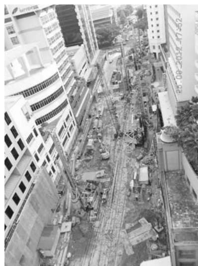
写真-4 連続柱列壁土留施工時の作業全景
