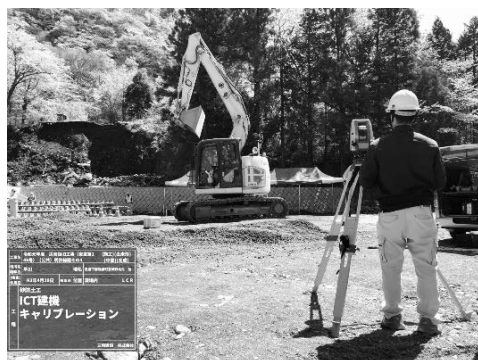
写真－9 ICT建機キャリブレーション
