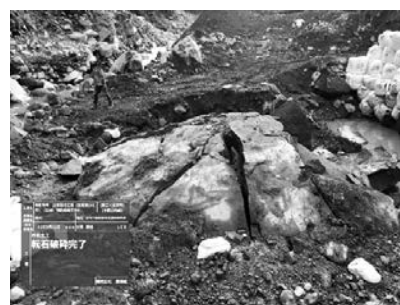
写真－8 転石破砕完了
