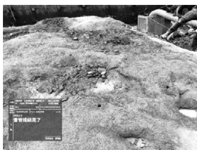
写真－7 雷管、破砕剤設置完了
