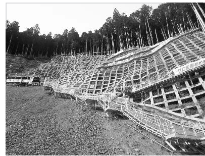
写真－7 昇降設備と材料置場
