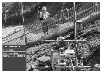
写真-18 法面ウォーカー
