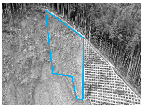
写真－12 施工箇所
