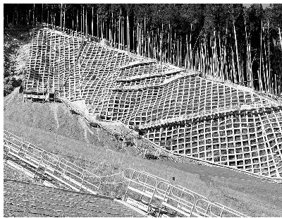
写真－5 各種仮設備
