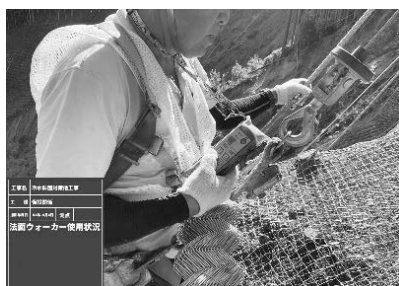
写真-19 昇降状況
