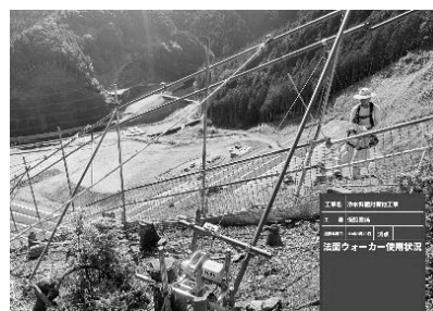
写真-20 昇降状況
