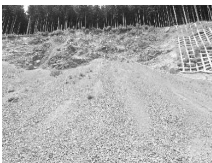
写真－2 施工前状況
