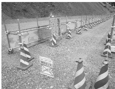
写真－6 作業通路
