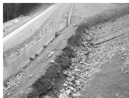
写真－4 落石対策
