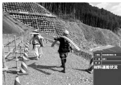
写真-15 アシストスーツ使用状況
