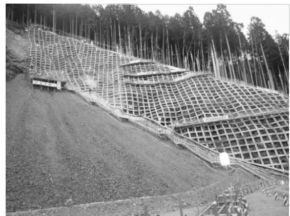
写真－1 施工状況
