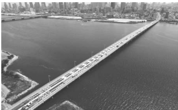
写真－1 淀川大橋
