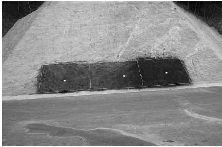
写真 4 施工時写真（H16年 1月）
