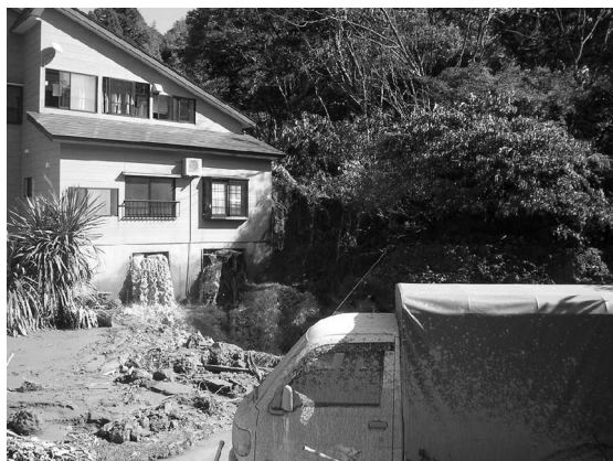
写真 4 河川埋塞による浸水被害（小千谷市浦柄）
