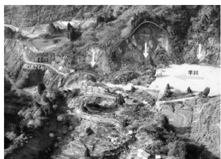
写真-6 山古志村寺野地区の河道閉塞状況
