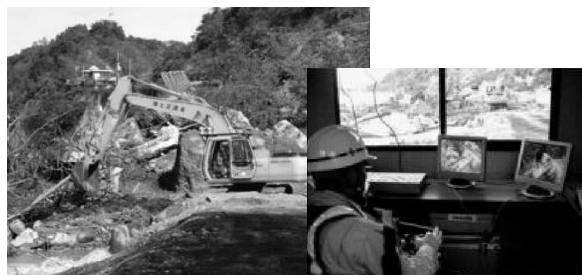
写真—8 遠隔操縦式バックホウと操作状況
