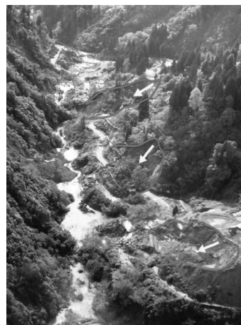
写真-4 山古志村梶金地先の 国道291号
