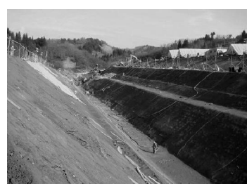
仮排水路（東竹沢地区）
