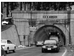
2車線で全面復旧 (12月26日)
