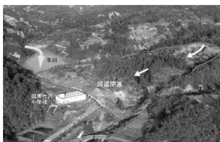
写真-5 山古志村東竹沢地区の河道閉塞状況
