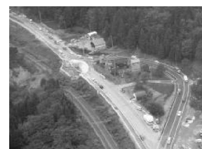
迂回路設置状況（10月29日）
