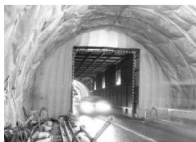
片側交互通行で復旧工事を 実施
