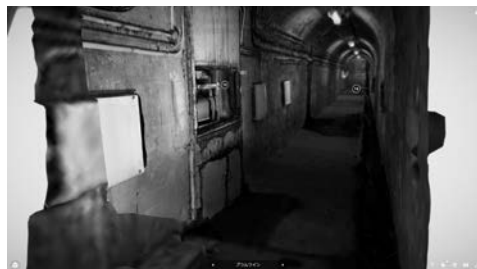
図-3 「3D バーチャル見学ツアー」で見た丸山ダム監査廊
