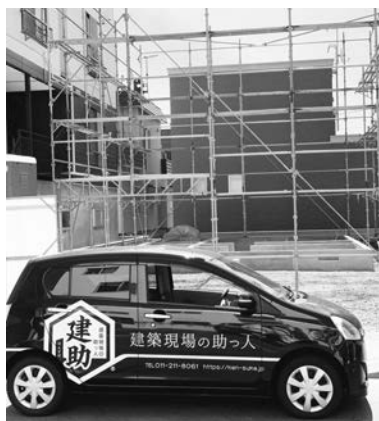
写真-1 建助スタッフ達は建助車両で全国の建築建設現場の下支えをしています
