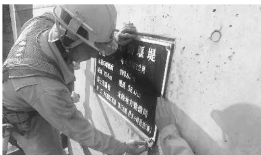
写真-14 銘板設置状況
