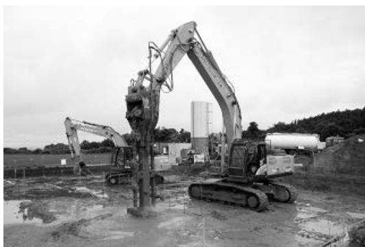
写真－9 中層混合処理機による施工状況
