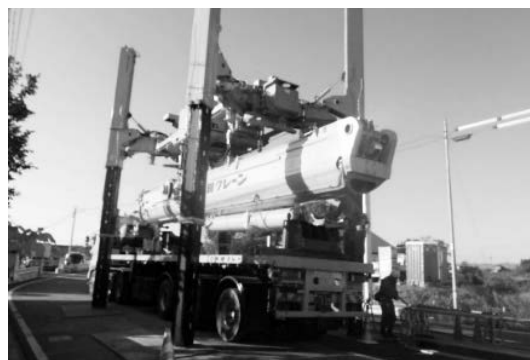
写真-8 リフターによる分解・組立
