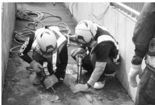
写真-5 既設薄層舗装はぎ取り状況
