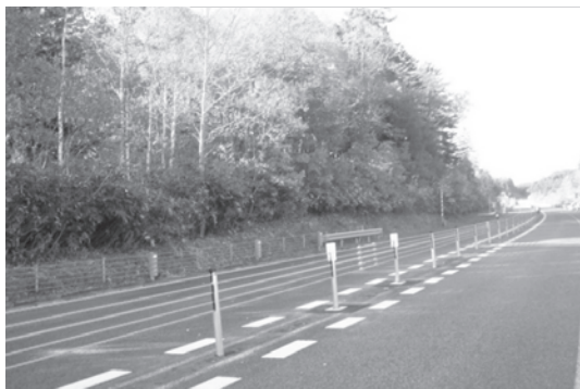
写真-1 ワイヤロープ設置状況 (全景)
