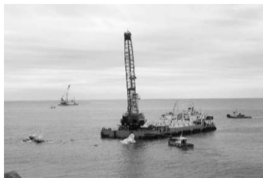
写真－12 ブロック据付状況
