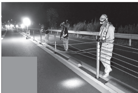
写真-2 ワイヤロープ作業状況
