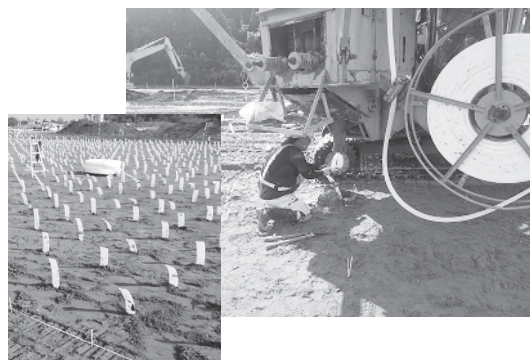
写真-4 ドレーン材打込み状況
