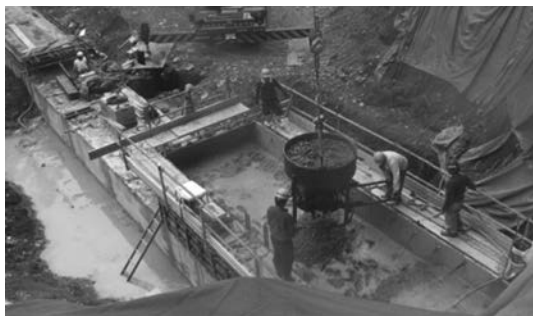
写真-13 コンクリート打設状況
