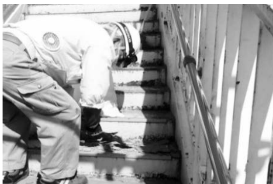
写真-6 ノンスリップ撤去状況
