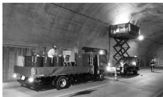
写真-16 注入作業状況 (全景)
