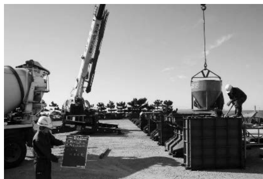
写真－11 ブロック製作状況
