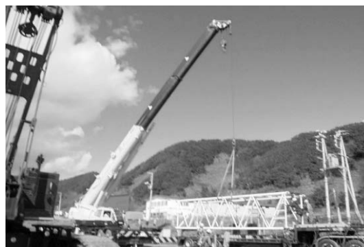
写真-7 ラフテレーンクレーンによる分解・組立
