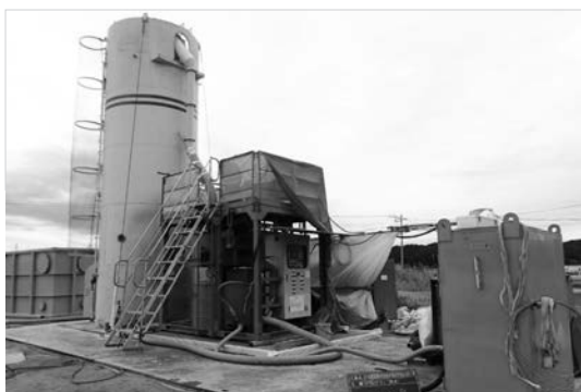
写真－10 スラリープラント設置状況
