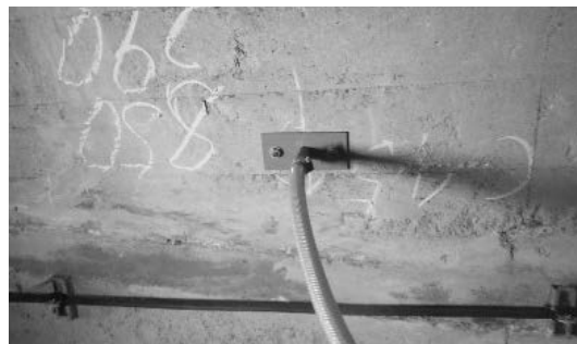
写真-15 注入作業
