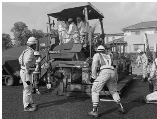
写真－5 舗装実習
