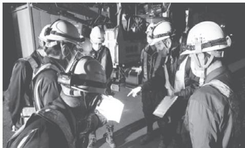
写真－10 作業前の現地KY活動の確認状況
