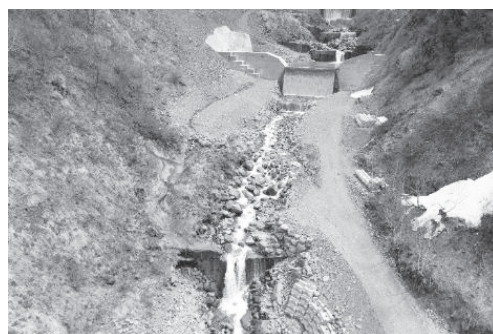
写真-1 コンクリート堰堤工（着工前）
