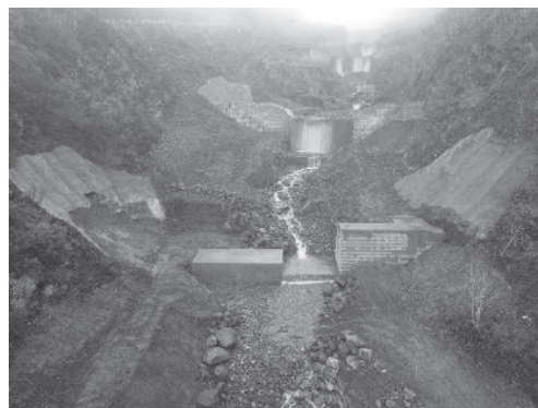
写真-2 コンクリート堰堤工（完成）
