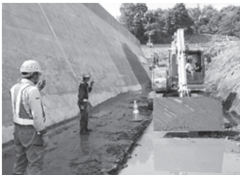
写真-12 トランシーバー合図状況
