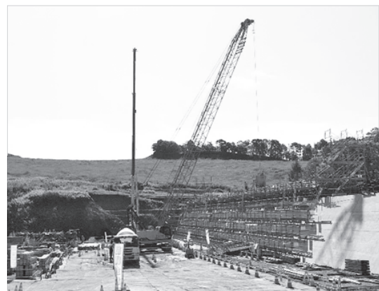
写真-10 クレーン打設状況
