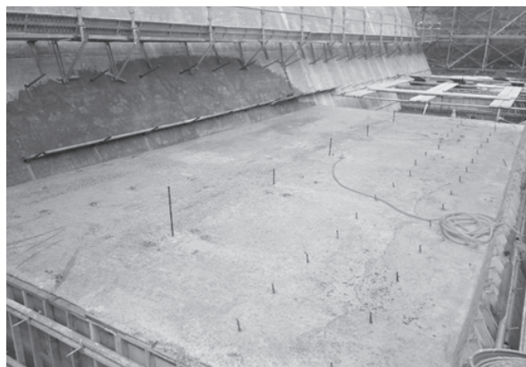
写真-13 自動散水養生状況
