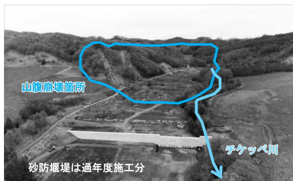
写真-1 砂防堰堤施工箇所周辺状況
